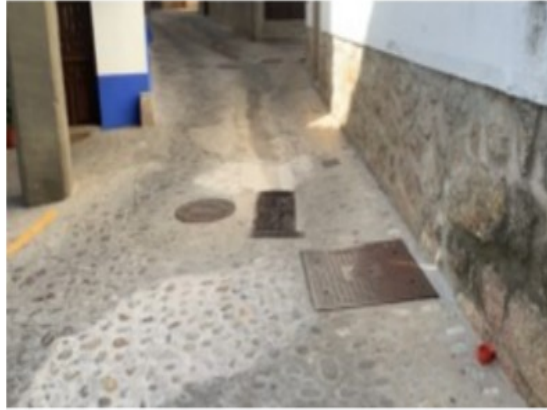
Tramo de Calle Cañada donde se sustituye abastecimiento y saneamiento.
