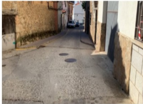
Final actuación Calle del Barrio.
