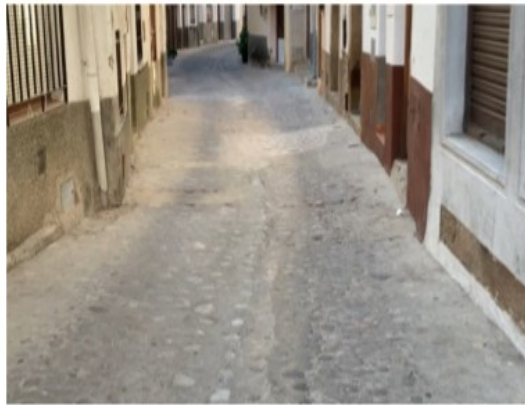
Vista general Calle del Barrio, zona de renovación redes de abastecimiento y saneamiento
