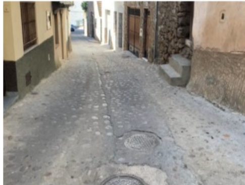
Vista general Calle del Barrio, zona de renovación de redes de abastecimiento
